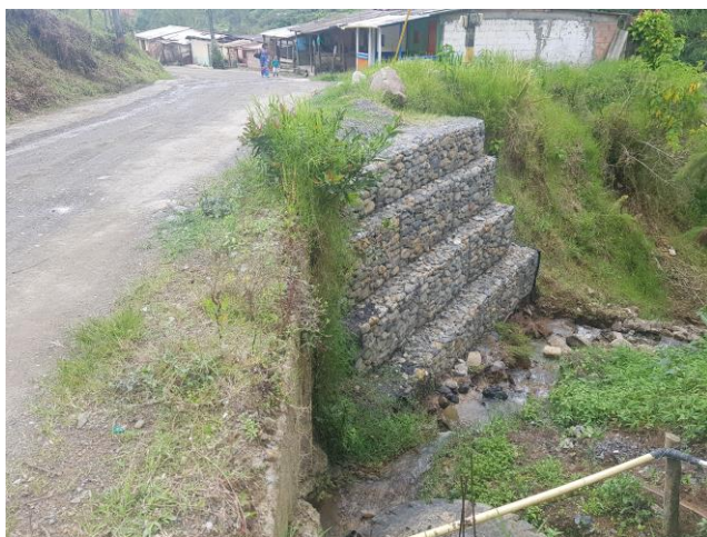
Foto 1. Muro en gaviones en el sector Villa Claret
