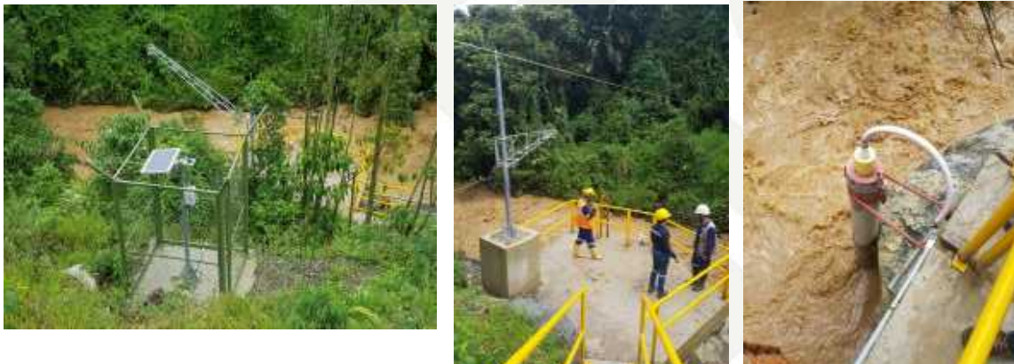
Figura 10. A. Estación hidrológica aguas arriba
