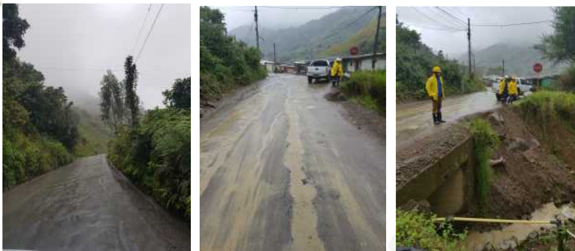
Figura 1. A. Escenario de riesgo producto de la avenida torrencial en Villa Clareth. B. Mantenimiento realizado a la vía de acceso.
