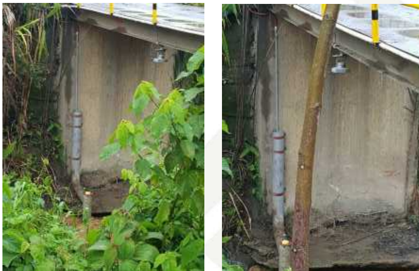
Figura 10 B. Estación hidrológicas aguas abajo.
